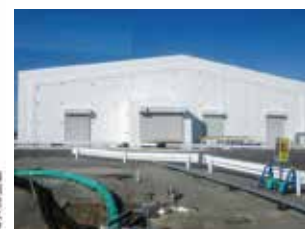
多核種除去設備
