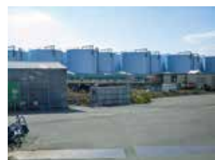
処理水タンク
